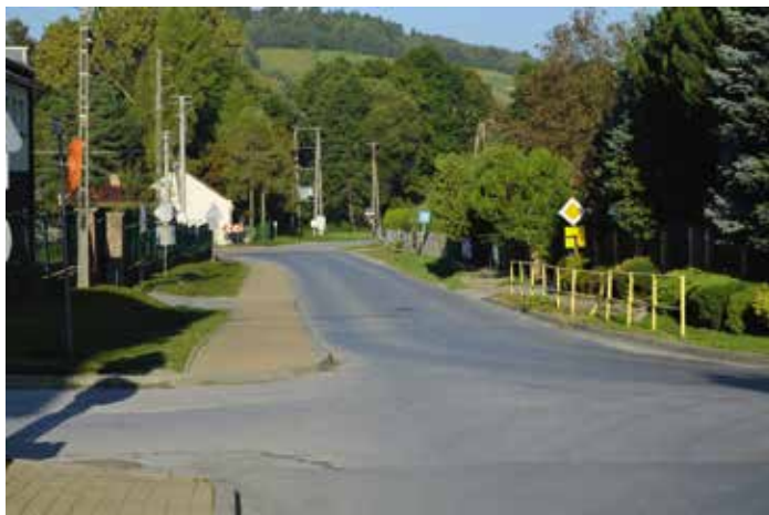
W ramach robót na odcinku o długości 127 metrów, od ulicy Spacerowej do ulicy Spokojnej, zaplanowano poszerzenie jezdni, budowę chodnika po stronie apteki z likwidacją rowu i budową kanalizacji deszczowej.
